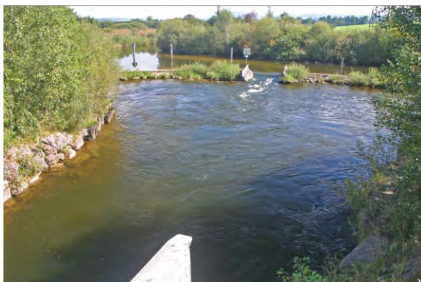
Abb. 5: Wallersee, Klauswehr Fischach; in der Mitte des 46 m breiten Hochwasserüberfalles liegt die Niederrwasserschwelle mit leichtem V-Profil (2010). Foto: Paul JÄGER
