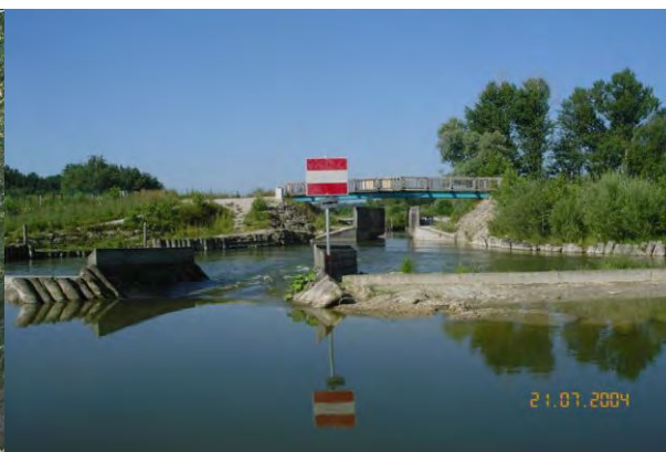
Abb. 6: Fischach, Damm und Klauswehr; im Vordergrund die Niederrwasserschwelle, unter der Brücke die Klausse, welche den See bei Hochwasser dynamisch rückstaut und damit Hochwasserspitzen im Abfluss dämpft. Foto: Paul JÄGER
